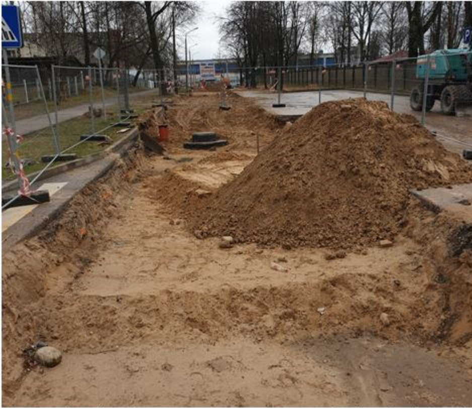
3.att. Lietus ūdens kanalizācijas sistēmas būvniecība būvobjektā Valkas ielā.
