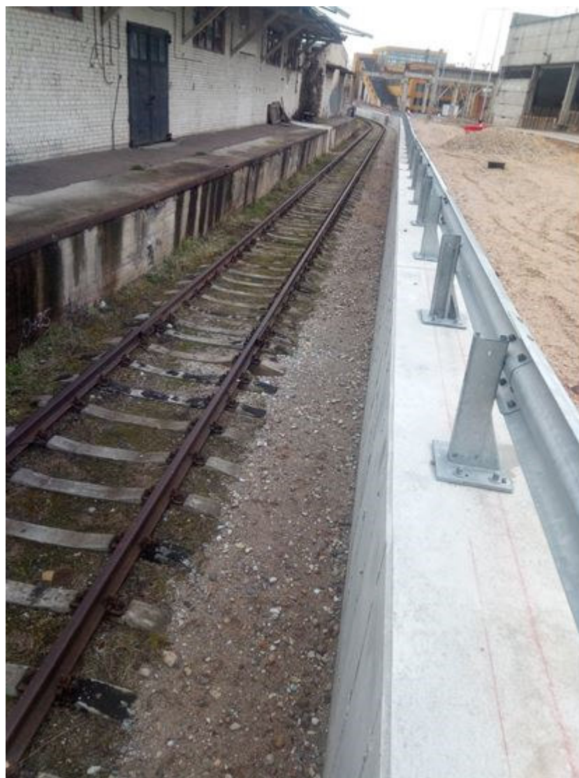
2.att. Izbūvēta atbalstsiena būvobjektā Silikātu ielā.
