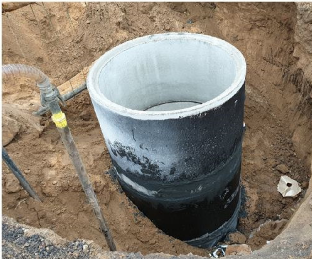
4.att. Sadzīves kanalizācijas sistēmas būvniecība būvobjektā Stikdu ielā.
