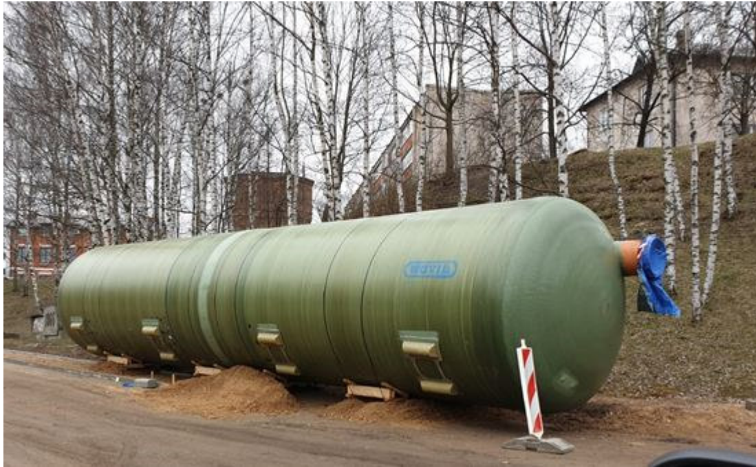
1.att. Notekūdeņu attīrīšanas iekārta būvobjektā Marijas ielā.
